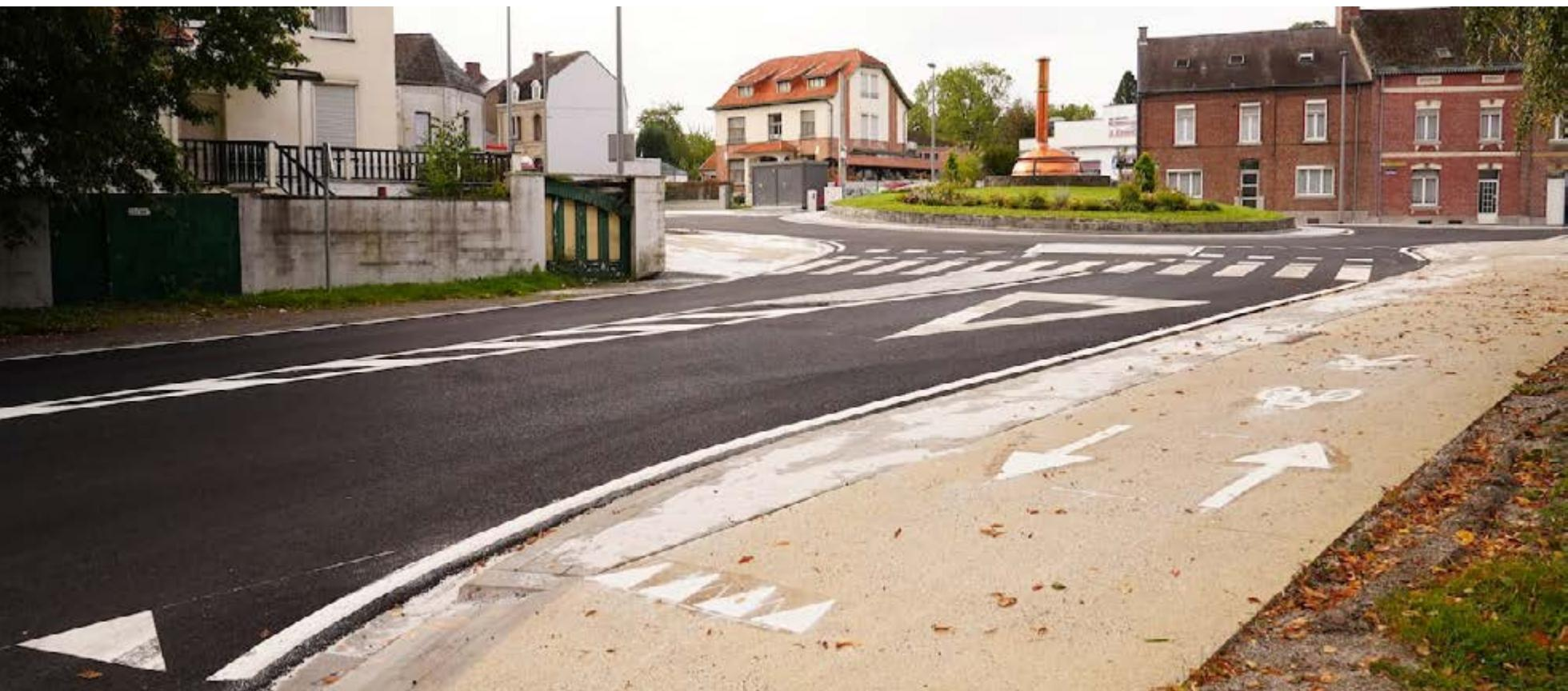
Toujours pour la mobilité douce, un trottoir a été réalisé au côté droit de la N99 pour remplacer l'ancien accotement avec un meilleur écoulement des eaux de pluie.
