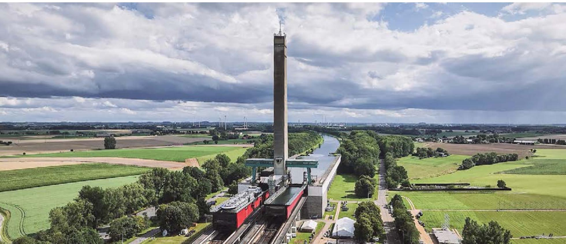
Après des travaux de renforcements structurels des bétons des trémies (parties) aériennes du plan incliné, les travaux se poursuivent en 2023 avec le lancement du chantier de remplacement des chemins de roulement et de guidage des deux bacs et contrepoids (près de 35 km) ainsi que des mécanismes de suspension et de guidage des deux bacs et contrepoids des deux bacs (près de 1.000 galets). Ces travaux dureront environ 6 ans, débutant par la rive gauche.
