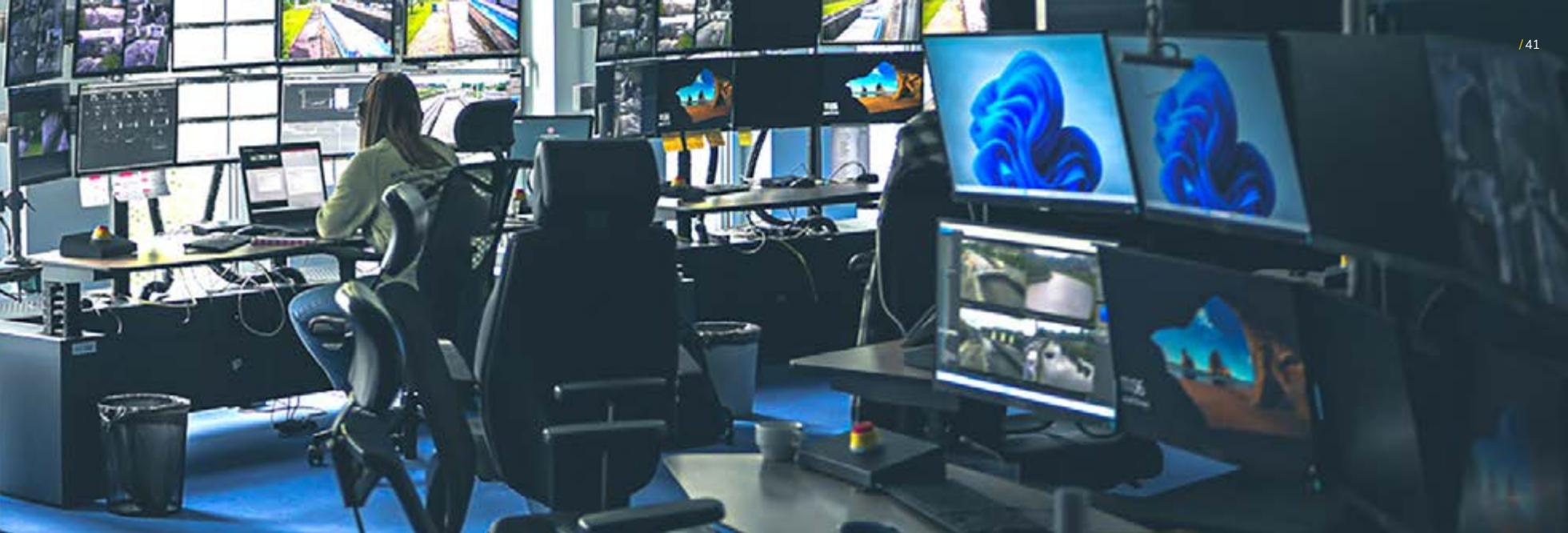
Ces évolutions ont été rendues possible grâce à la modernisation en cours des sites éclusiers. Outre l'installation d'une quinzaine de caméras HD sur chaque site, les automates locaux ont été remplacés par des solutions plus récentes et performantes et chaque site a fait l'objet d'un raccordement au réseau de fibres optiques que le SPW MI développe et exploite pour le compte de la SOFICO.
