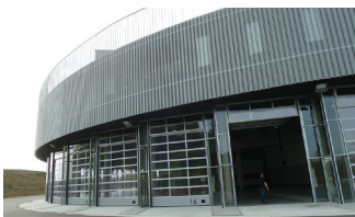
Caserne des pompiers 6000 Charleroi Maître d'ouvrage : Ville de Charleroi Surface : 20.000 m 2 Coût : 30.230.825 € TVAC Réalisation : 2016
