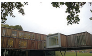
Hôtel de Ville 6110 Montigny-Le-Tilleul Maître d'ouvrage : Ville de Montigny-Le-Tilleul Surface : 5.000 m 2 Coût : 6.533 € TVAC Réalisation : 2014
