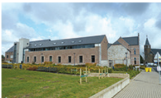
Restauration et rénovation de la ferme Mottet 4520 Wanze Maître d'ouvrage : Commune de Wanze Surface : 5.200 m 2 Coût : 8.708.568 € TVAC Réalisation : 2012
