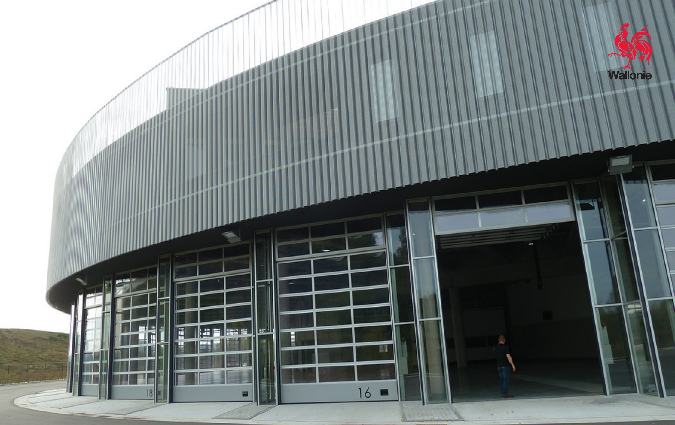
Caserne des pompiers de Charleroi
