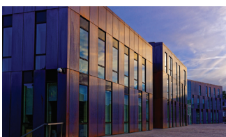
Maison communale/CPAS 5030 Gembloux Maître d'ouvrage : Commune de Gembloux Surface : 8.960 m 2 Coût : 10.600.000 € TVAC Réalisation : 2015
