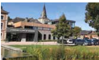
Administration communale de Nandrin Maître d'ouvrage : AC de Nandrin Surface : 900 m 2 Coût : 1.778.595 € TVAC Réalisation : 2018
