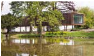
Maison communale, centre culturel et locaux pour le CPAS de Fosses-la-Ville Maître d'ouvrage : Ville de Fosses-la-Ville Coût : 4.464.802 € Surface : 3.420 m 2 Réalisation : 2018
