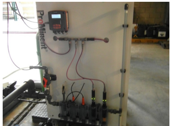
Figure A. 7.10 : Mouscron : Nouveau mesurage Cl + pH
