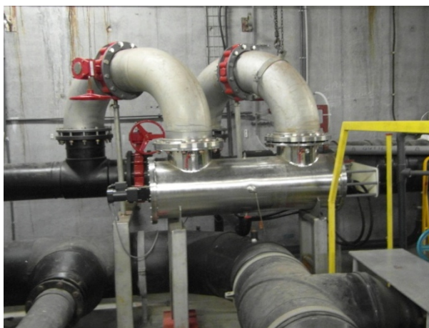
Figure 4.6 : Réacteur UV de la grande piscine Les Dauphins, Mouscron
