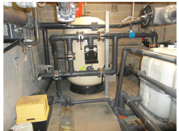
Figure A. 6.4 : Marche-en-Famenne : Traitement de l'eau petit bassin
