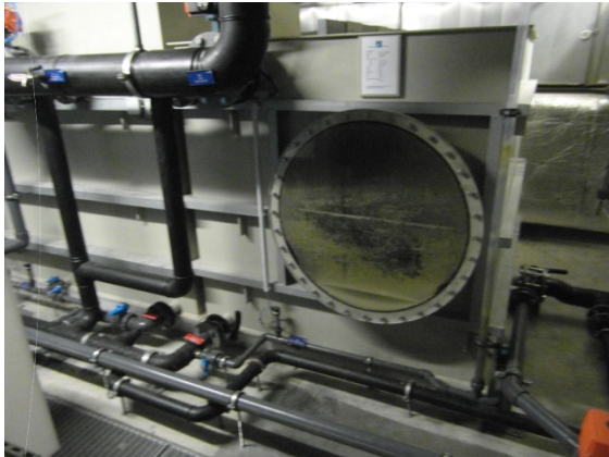
Figure A. 10.9 : Lünen : bac tampon en plastique
