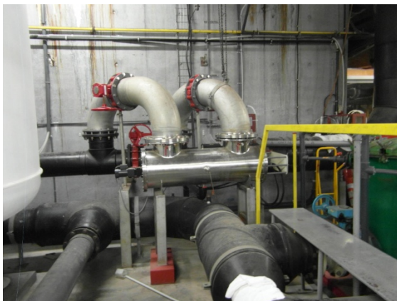
Figure A. 7.5 : Mouscron : Réacteur UV petit bassin
