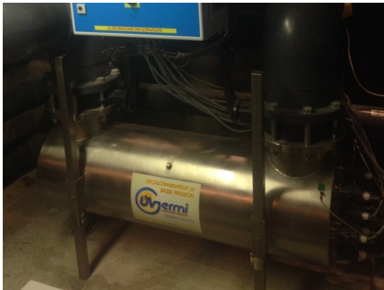
Figure A. 9.3 : Waterloo : Réacteur UV
