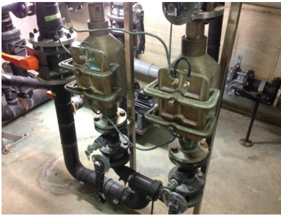
Figure A. 5.3 : Louvain-la-Neuve : Batteries de cuivre patageoire
