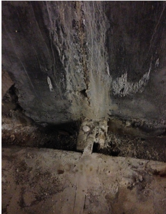
Figure A. 1.5 : Charleroi : Joint de dilatation grand bassin
