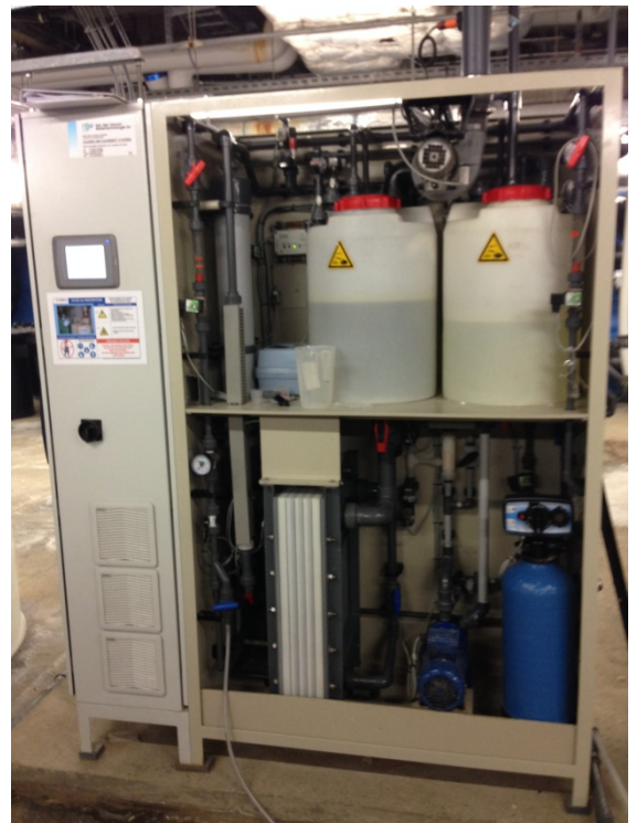
Figure A. 1.6 : Charleroi : Électrolyse de sel
