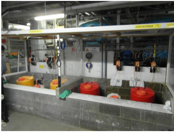
Figure A. 7.9 : Mouscron : Ancien mesurage Cl + pH
