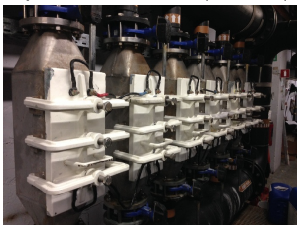
Figure 4.2 : Batteries de cuivre dans la piscine du Blocry
