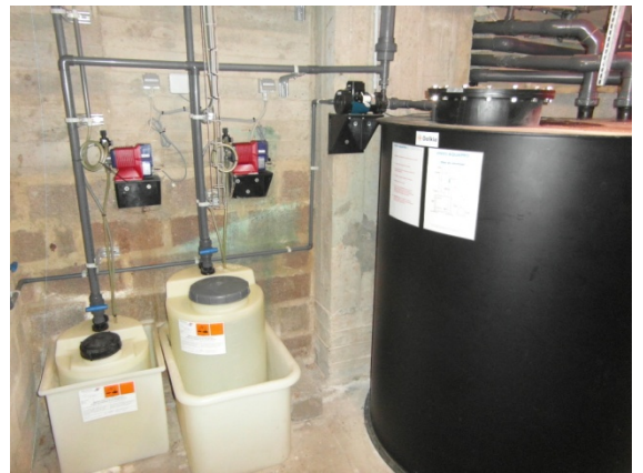
Figure A. 3.4 : Grivegnée : Nouveau stockage produits chimiques
