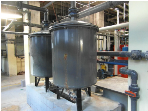
Figure A. 8.3 : Namur : Filtres à diatomées
