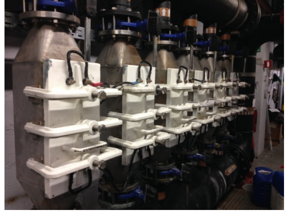
Figure A. 5.4 : Louvain-la-Neuve : Batterie d'argent patageoire
