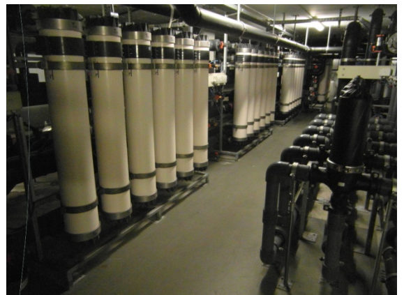
Figure A. 10.6 : Lünen : ultrafiltres
