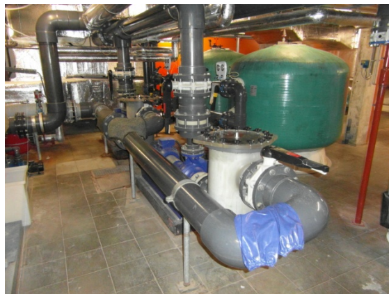
Figure A. 6.3 : Marche-en-Famenne : Traitement de l'eau grand bassin
