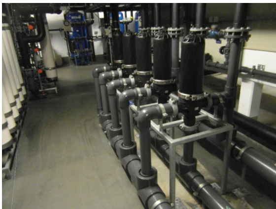
Figure A. 10.5 : Lünen : préfiltres
