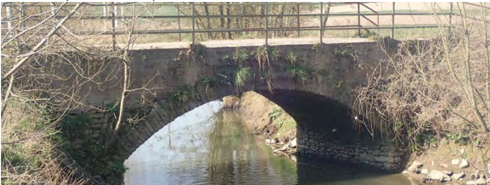
Voûte en maçonnerie à Rebecq.
