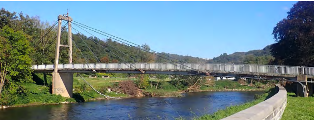
Passerelle haubanée à Tilff.
