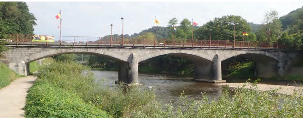
Pont à trois travées à Comblain-Fairon.
