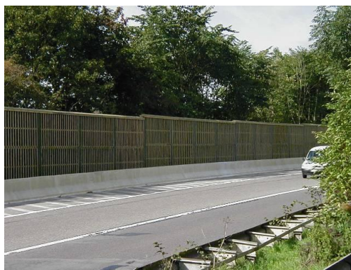
Réalisation d'écrans antibruit métalliques et en bois
