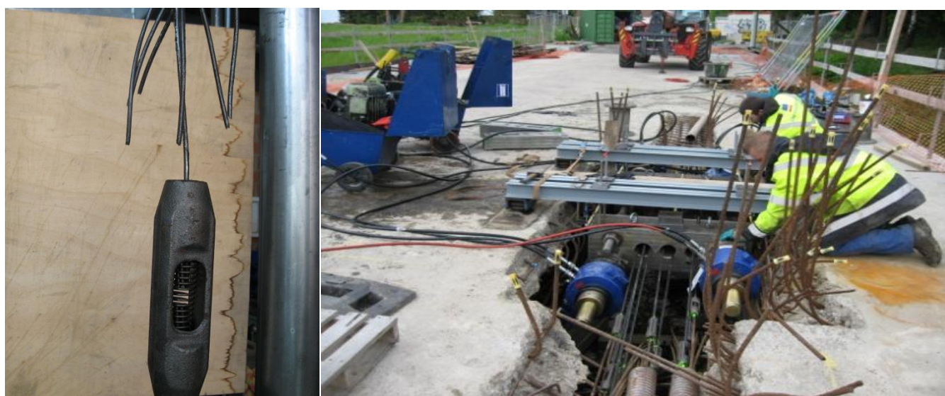
Réparations de câbles de précontrainte – Réception des coupleurs – Mise en oeuvre
