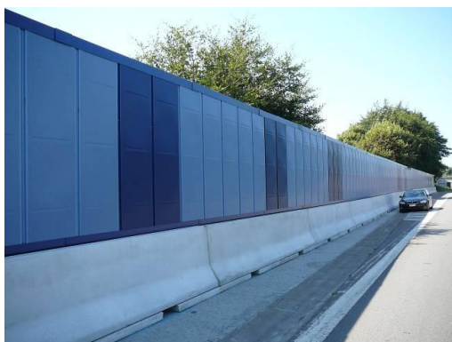
Réalisation d'écrans antibruit métalliques et en bois
