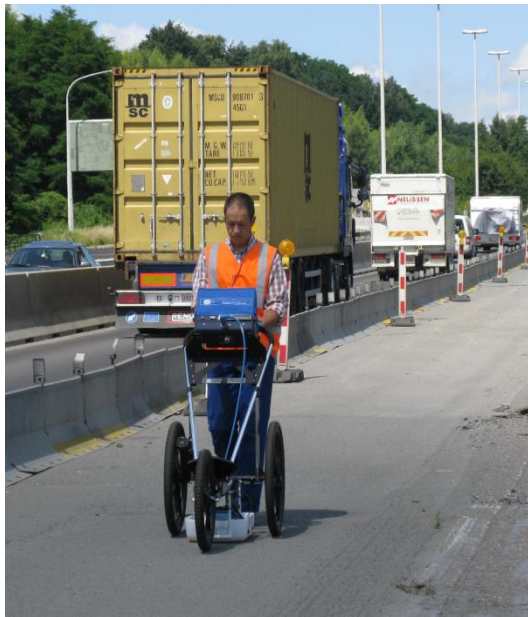
Inspection d'une face supérieure de tablier à l'aide du radar
