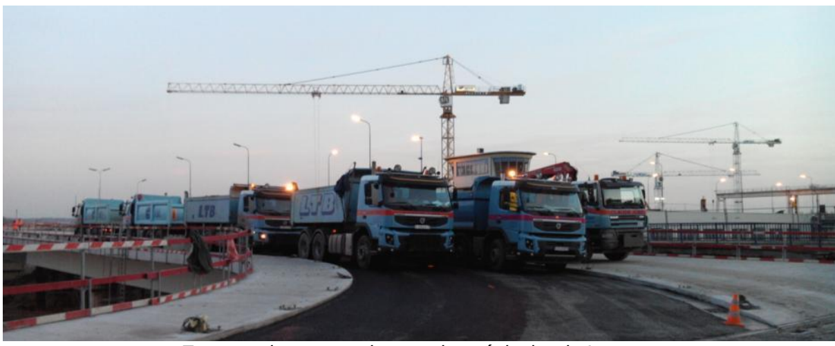
Epreuve de pont sur le complexe éclusier de Lanaye
