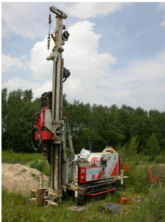
Forages de reconnaissance géotechnique.
