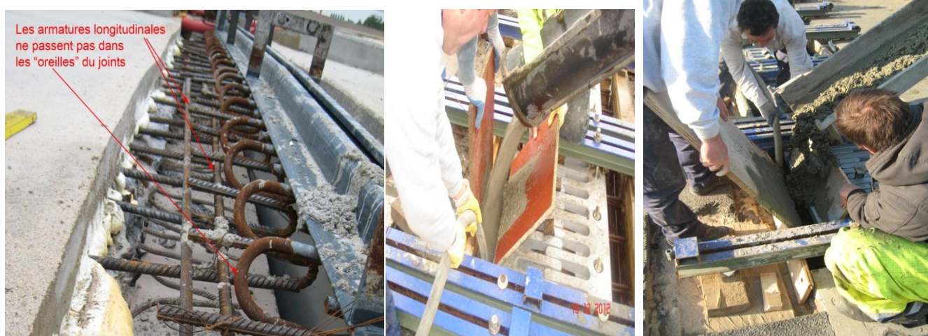
Mise en œuvre de joint de dilatation : Contrôle de ferrailage – ouverture du joint – suivi bétonnage
