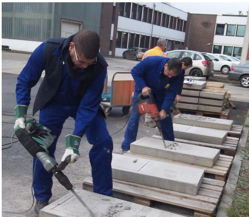
Etude interne sur les paramètres influençant l'adhérence des réparations
