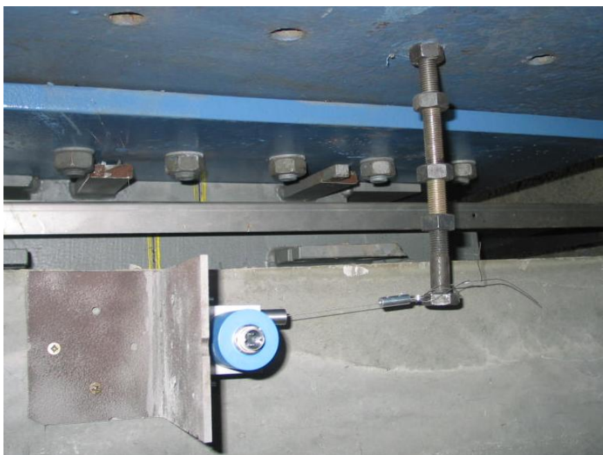
Mesure du déplacement d'un appui au viaduc de Beez
