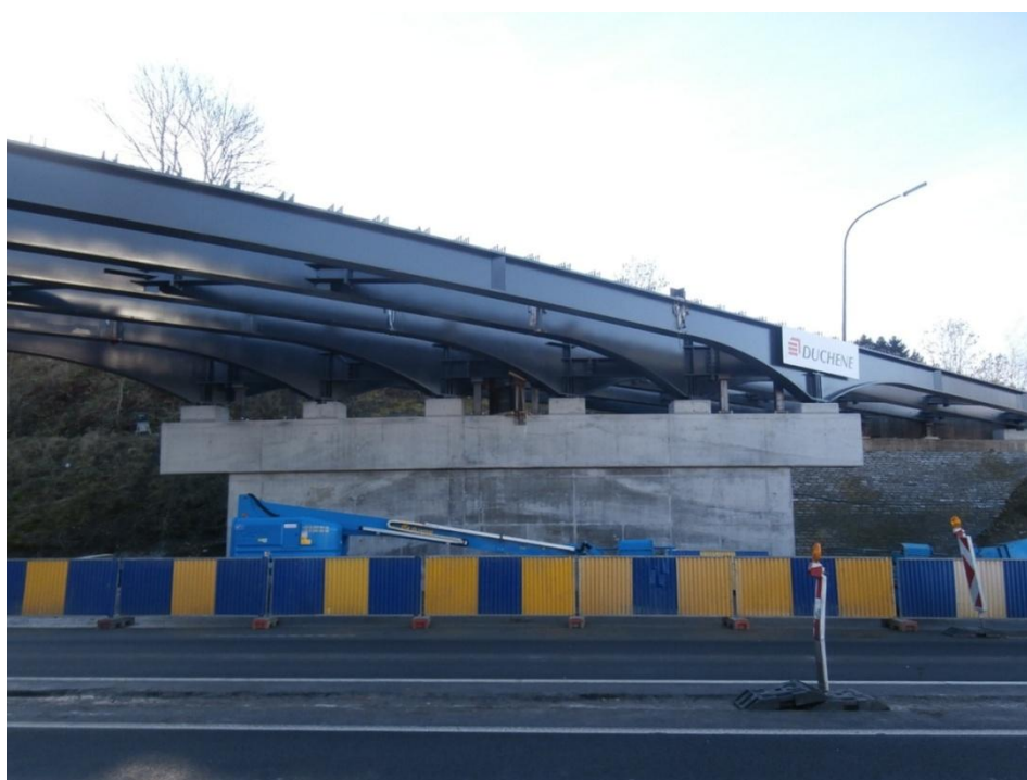
Pont de La Roche à Marche-en Famenne
