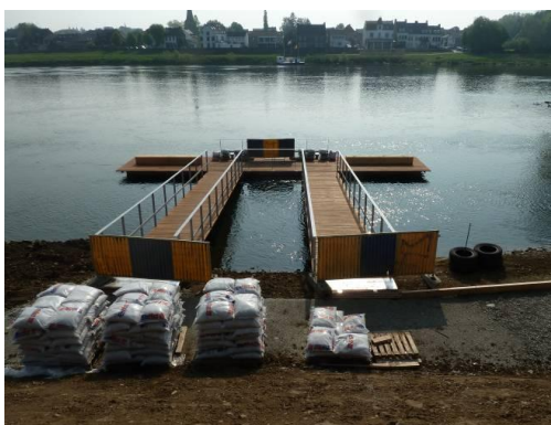
Réalisation d'un embarcadère (écluse de Lanaye)
