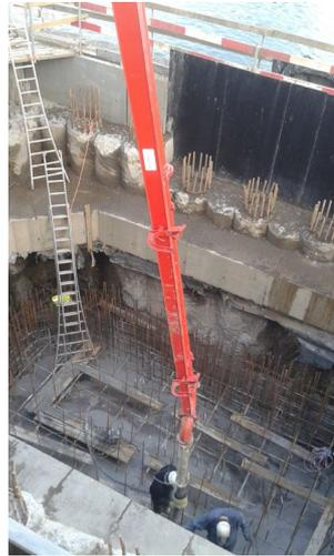
Fondation des piles et de la culée de la rampe côté Jambes :
