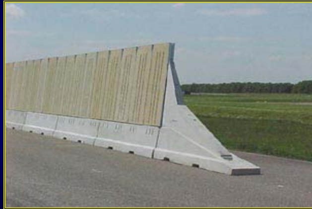
"Dispositifs de retenue routiers"
