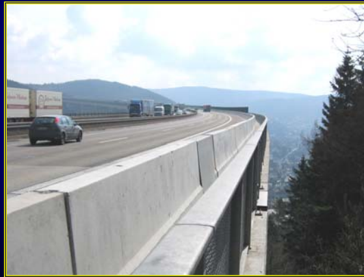
"Dispositifs de retenue routiers"
