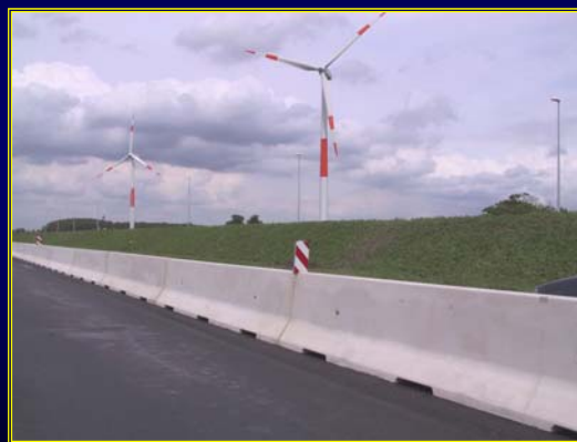
"Dispositifs de retenue routiers"
