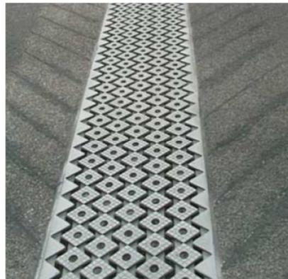
Joint avec dispositif anti-bruit
