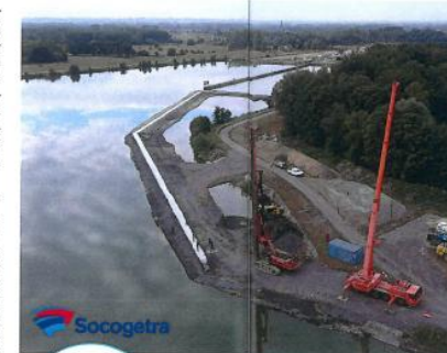
Le chantier se situe à la jonction entre le canal Nimy-Blaton et celui de Condé (France)-Pommeroeul.
