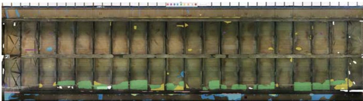
Orthophoto d'une zone de 80m de longueur du viaduc d'Horion permettant une visualisation globale directe des défauts
