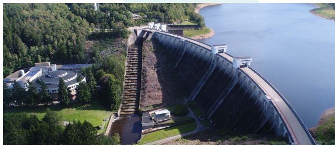
Een complex dat permanent in de gaten wordt gehouden. De overlaat waarmee 230 m 3 /s afgevoerd kan worden. © SPW MI (DBR)
