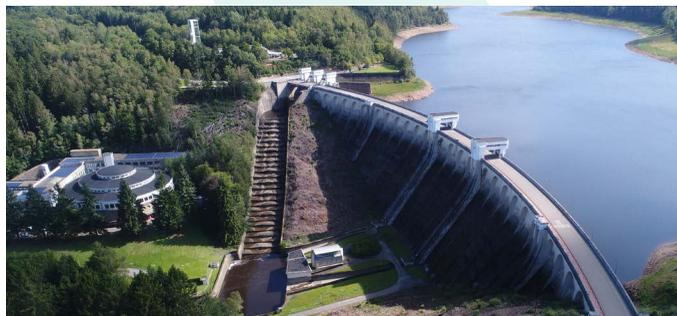
Un site contrôlé en permanence. Au centre, le déversoir qui permet l'évacuation de 230 m<sup>3</sup>/s. Au fond, la tour et le restaurant. © SPW MI (DBR)
