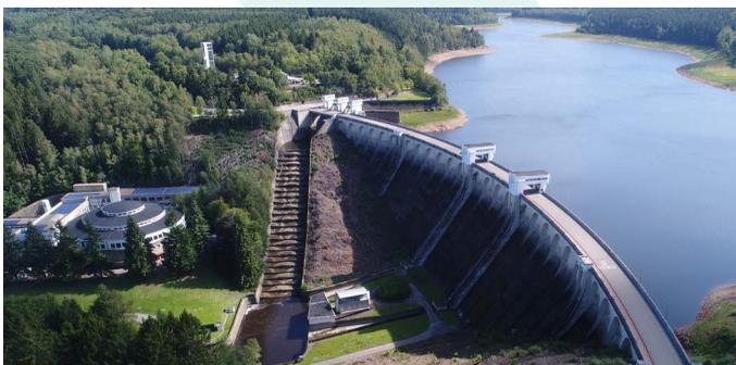
Ein Gelände, das ständig kontrolliert wird. Der Überlauf, der die Ableitung von 230 m³/s ermöglicht. © ÖDW MI (DBR)
