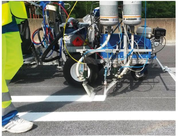
Les peintures sont utilisées uniquement sur les routes régionales et non sur les autoroutes afin de limiter les embarras de circulation qui pourraient être causés par des travaux de marquage trop fréquents. En effet, un marquage en peinture doit être renouvelé chaque année. Or, l'enduit à chaud (pas nocif pour la santé) a une durée plus longue mais il est aussi plus cher que la peinture.
