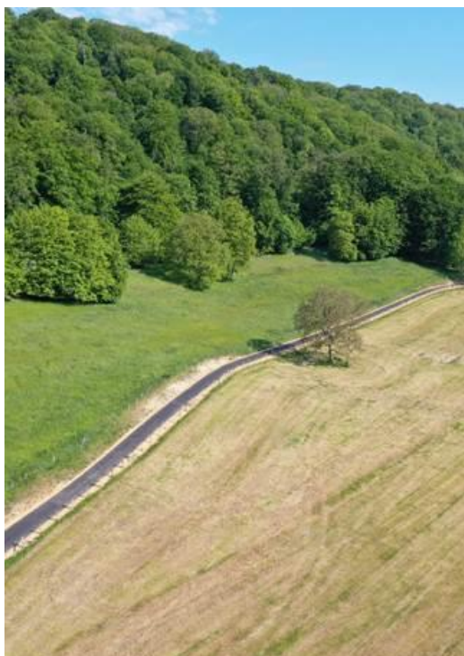
© Ministère de la Mobilité et des Travaux Publics (MMTP – PCH)
