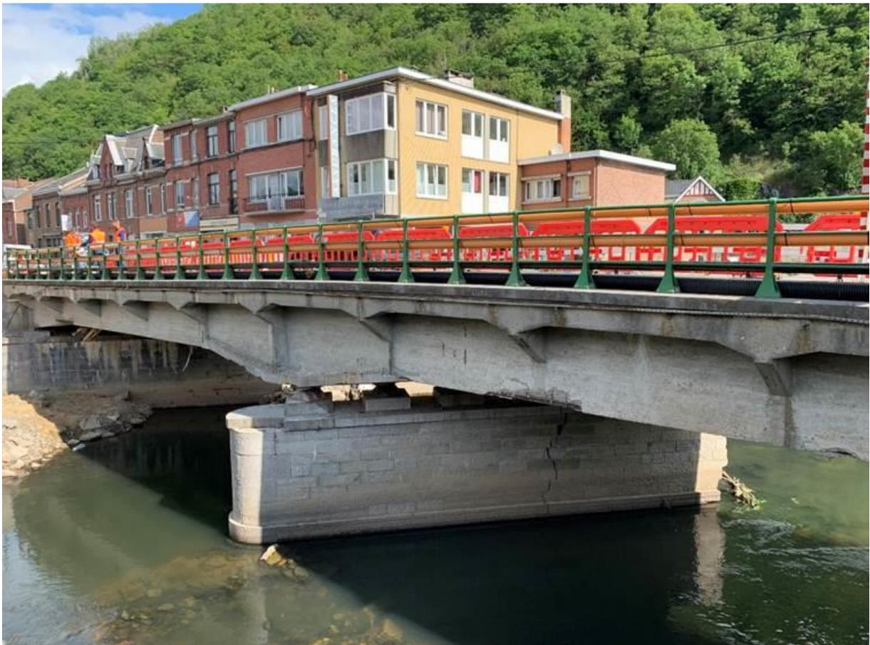
Les travaux du pont de Prayon vont entrer dans une nouvelle phase le 11 août prochain. Concrètement, deux grues de 100 et 120 tonnes seront acheminées sur le site en matinée. Elles permettront de poser les poutres qui constitueront l'assise de la 2<sup>e</sup> moitié aval du pont. Les opérations se poursuivront le samedi 12 août notamment avec le placement de garde-corps provisoires.
